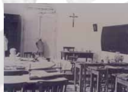
Sala de labores de la Escuela Normal de maestros de Huelva.
